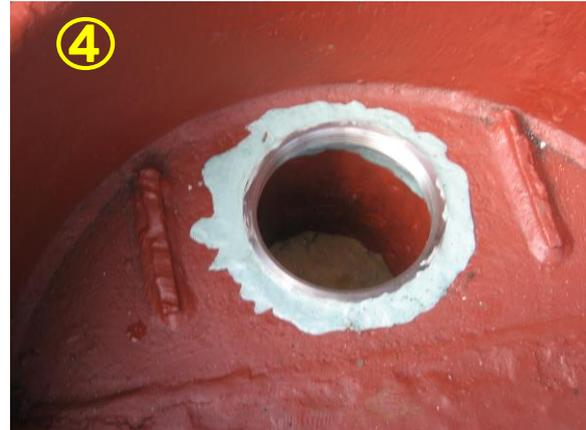
③ウエスを置いたままで固定用ネジ（止めネジ）を六角レンチで回しリング外周に出し、排水口に固定する。固定用ネジ（止めネジ）はリング内側に突出しないサイズを使用。ウエスを取り除く。
